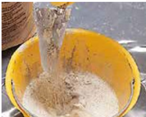
Préparation de la barbotine d'accrochage composée de Topcem et de Planicrete Latex
