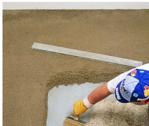
Application de la barbotine d'accrochage pour chape adhérente Topcem
